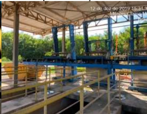
Figura 243 – Resíduos retirados mecanicamente das grades médias e dispostos em caçambas.
