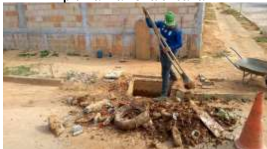
Figura 138 – Exemplo da limpeza e desobstrução do sistema de drenagem pluvial na zona urbana.
