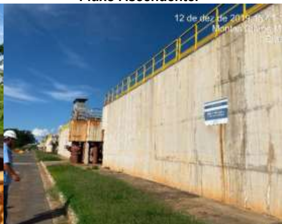
Figura 249 – Reatores Anaeróbios de Fluxo Ascendente.
