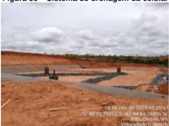
Figura 86 – Sistema de drenagem da célula.
