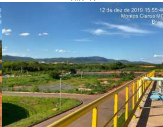
Figura 259 – Aterro visto pela cobertura dos reatores.
