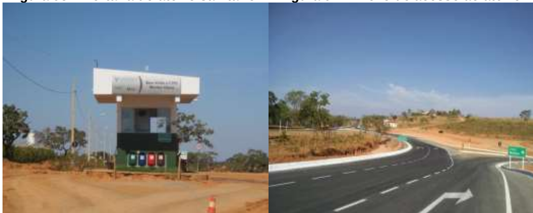
Figura 93 – Portaria do aterro sanitário. Figura 94 – Trevo de acesso ao aterro.
