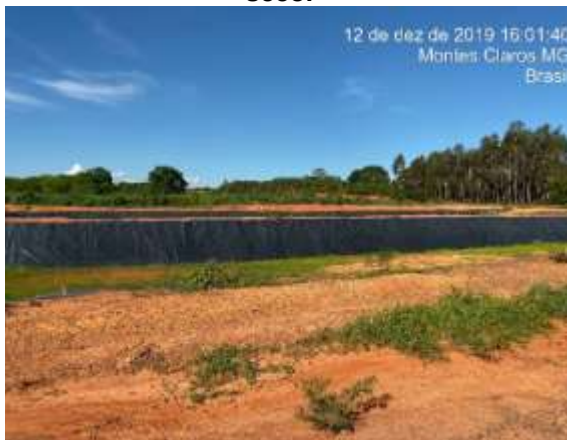
Figura 258 – Aterro com duas valas, dentro da área da ETE, onde é disposto o lodo seco.
