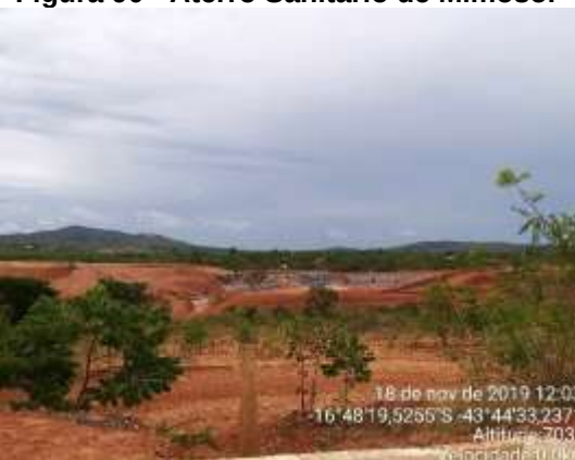
Figura 90 - Aterro Sanitário de Mimoso.
