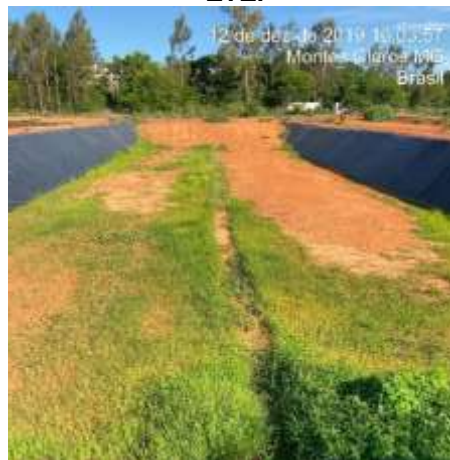
Figura 261 – Uma das valas do aterro da ETE.
