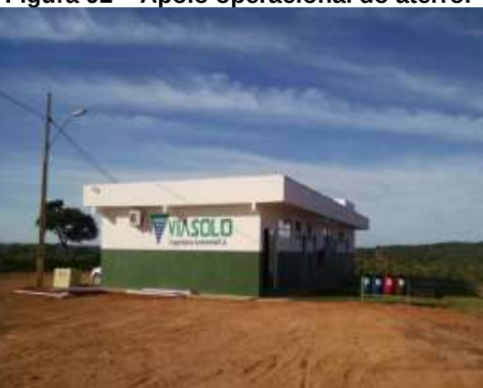
Figura 92 – Apoio operacional do aterro.
