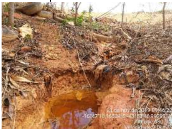
Figura 195 - Situação atual do Aterro Municipal de Montes Claros-MG.
