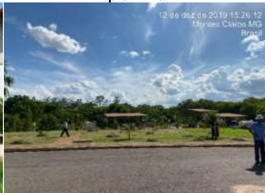
Figura 237 - Visão Geral do tratamento preliminar.
