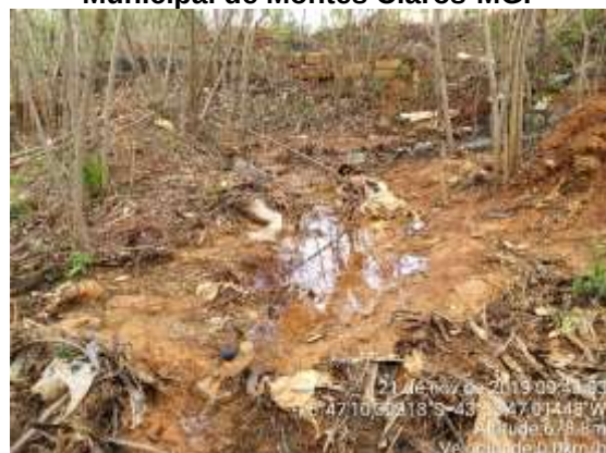
Figura 194 - Situação atual do Aterro Municipal de Montes Claros-MG.
