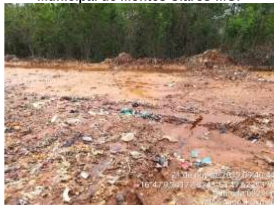
Figura 192 - Situação atual do Aterro Municipal de Montes Claros-MG.
