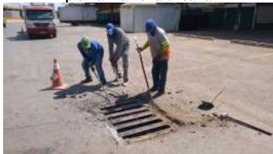
Figura 139 – Exemplo da limpeza e desobstrução do sistema de drenagem pluvial na zona urbana.
