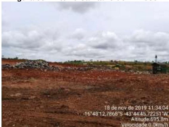
Figura 85 – Aterro Sanitário de Mimoso.
