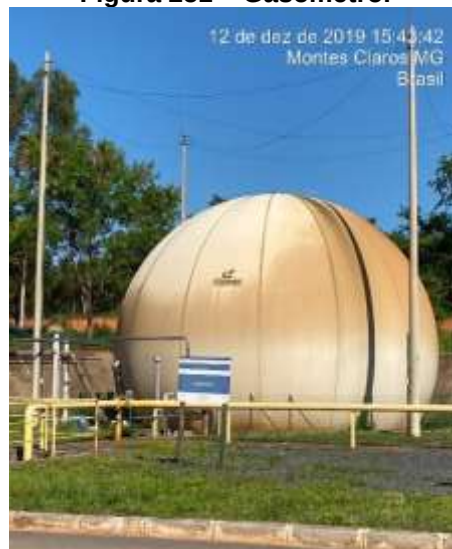
Figura 251 – Gasômetro.
