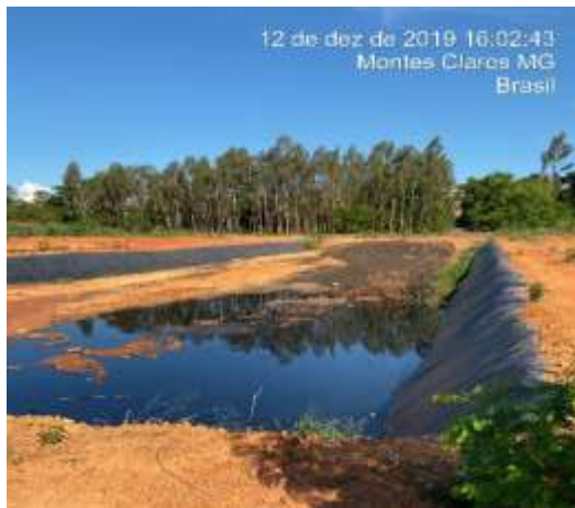
Figura 260 – Uma das valas do aterro da ETE.
