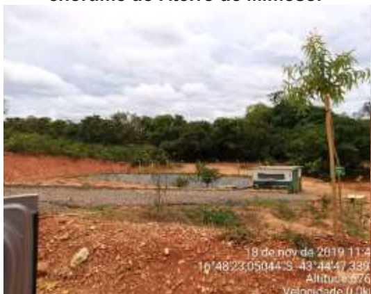
Figura 87 – Lagoa de acumulação de chorume do Aterro de Mimoso.
