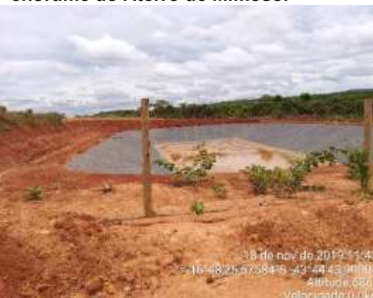
Figura 88 - Lagoa de acumulação de chorume do Aterro de Mimoso.
