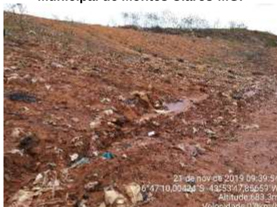
Figura 190 - Situação atual do Aterro Municipal de Montes Claros-MG.
