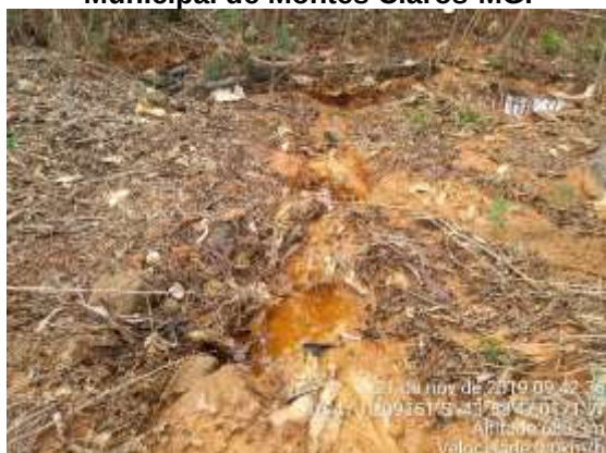
Figura 193 - Situação atual do Aterro Municipal de Montes Claros-MG.
