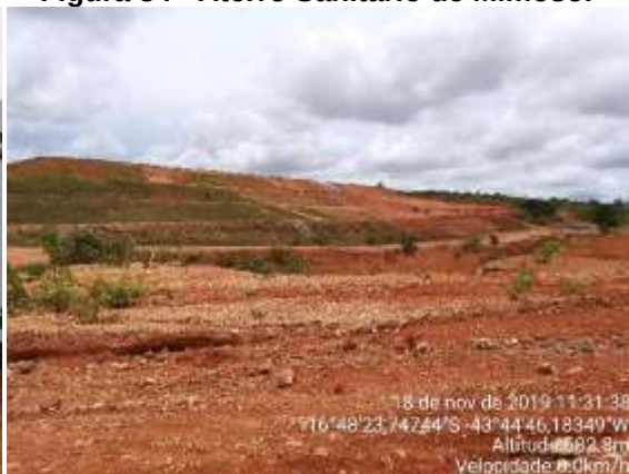
Figura 84 - Aterro Sanitário de Mimoso.
