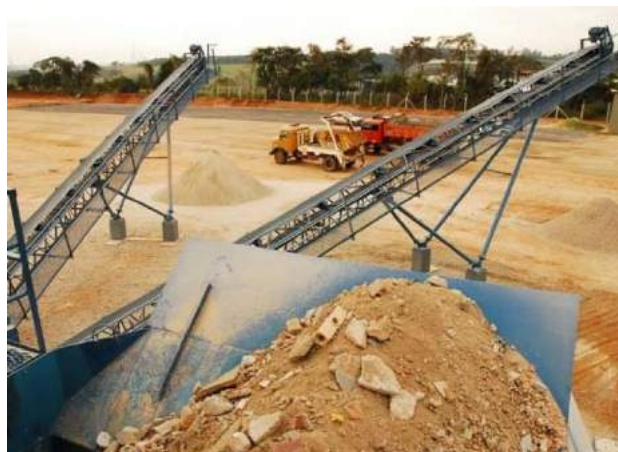
Figura 95 – Aterro resíduos inertes.
