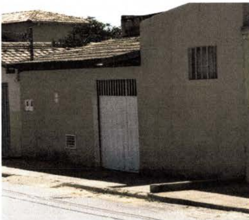
Fachada do imóvel situado à Rua Eduardo de Almeida, N° 190, Delfino Magalhães, que fecha o acesso à Rua Roque Ferreira Pimenta (antiga Rua C)
